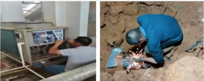
昆明理工大学津桥学院针对常修常发的地下管网漏水问题，反复排查逐渐锁定漏水范围，妥善维修管线漏点，顺利取得《水量平衡测试合格证》，修复后年节水约 109500 吨，节约用水成本 49 万余元
