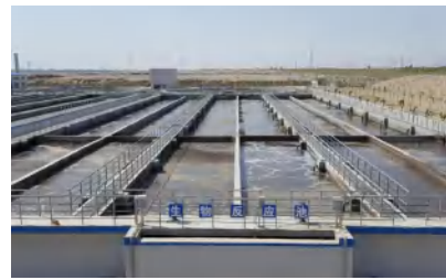
库尔勒经济技术开发区工业废水处理回用 厂生物反应池
